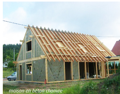
maison en béton chanvre
